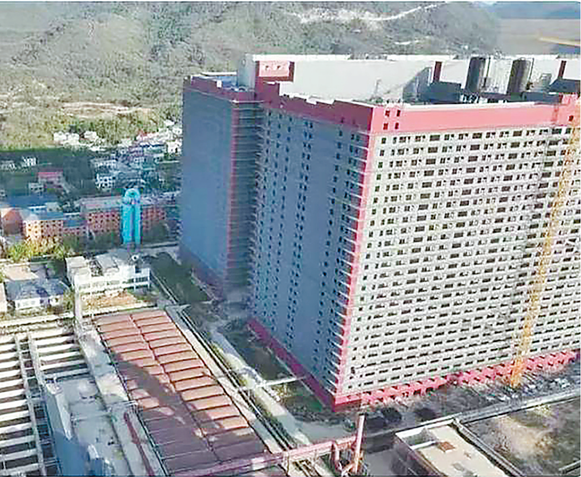
中新开维现代牧业26层养猪场。（受访单位供图）
