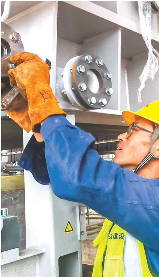
云图磷化工产业园建设如火如荼，工人在安装设备。
