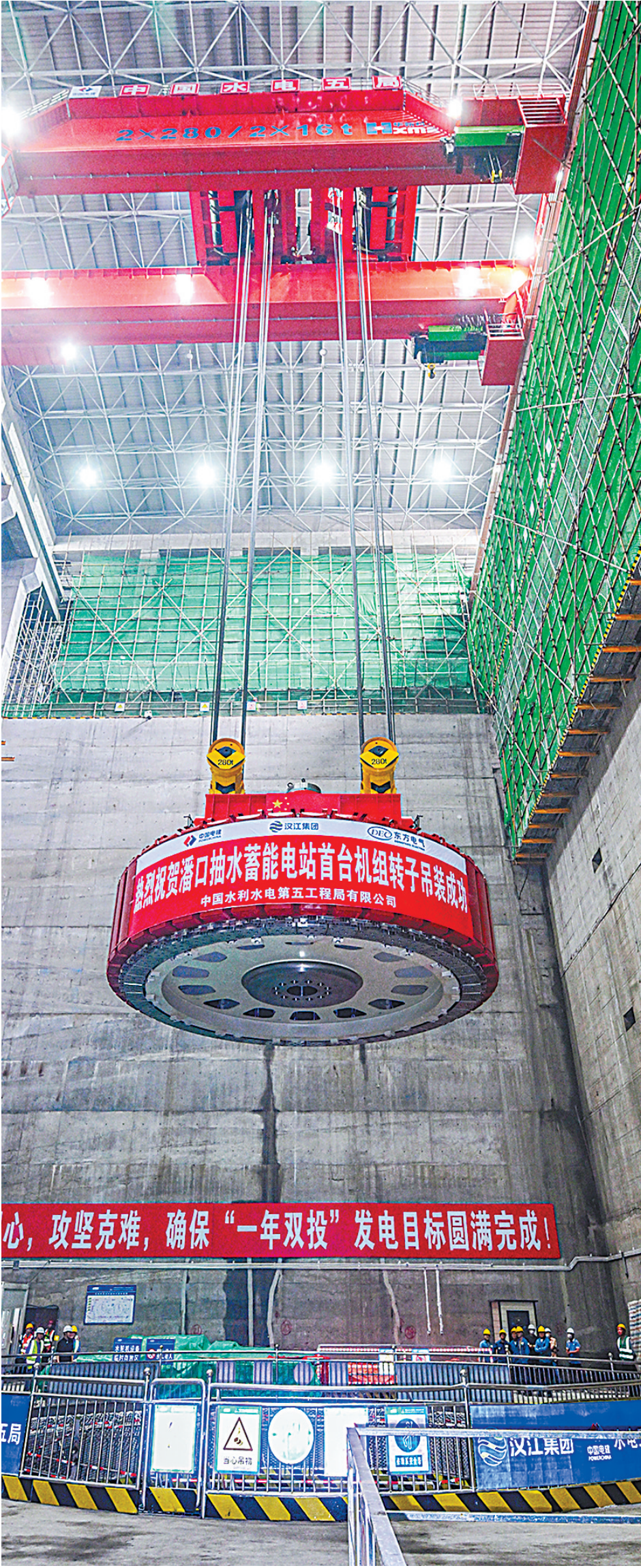
竹山县潘口抽水蓄能电站发电项目首台机组转子吊装成功。(视界网 石濡华 张渊 摄)
