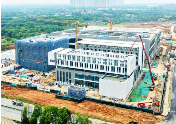
正在建设的红莲湖半导体产业园。（肖运泉 摄）
