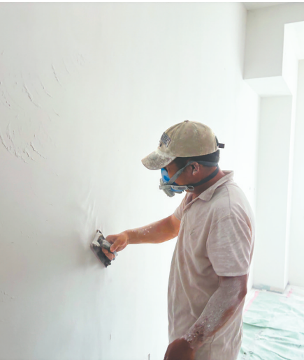
人工打磨方式,劳动强度大,灰尘大。
