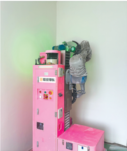
机器人正在进行打磨作业。
