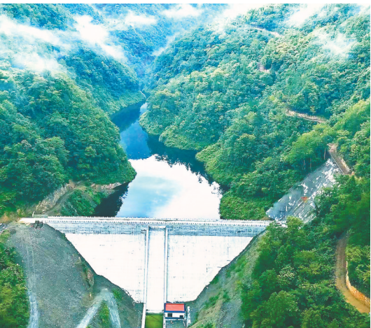
建始小河沟水库建成通水。(受访单位供图)
