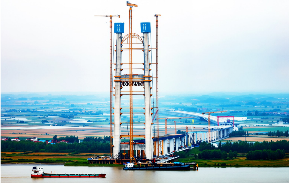
汉南长江公路大桥主塔顺利封顶。
