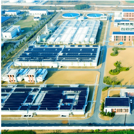
观南路污水处理厂是荆州首座绿电驱动的工业污水处理厂,每年可节约标煤975吨,减少二氧化碳排放约2600吨,节省电费支出超过百万元。
