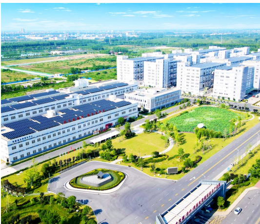
金茂源(华中)表面处理循环经济产业园的“深蓝屋顶”。
