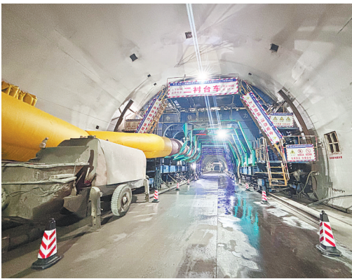
襄宜高速长坂坡隧道穿越雾渡河断裂带。(湖北日报通讯员 杨思思 摄)
