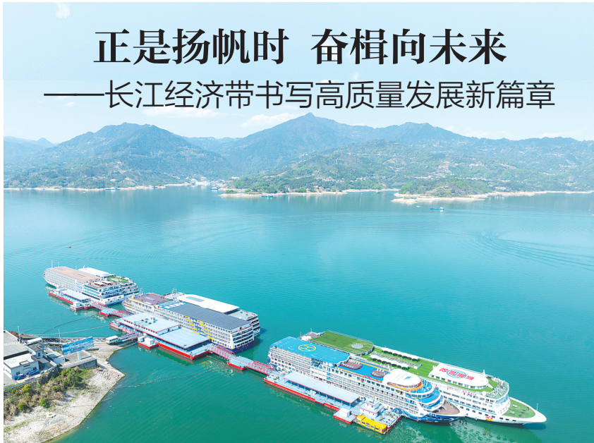
4月1日,船舶停靠在配有“清洁岸电”设施的三峡库区秭归港码头。(新华社发)
