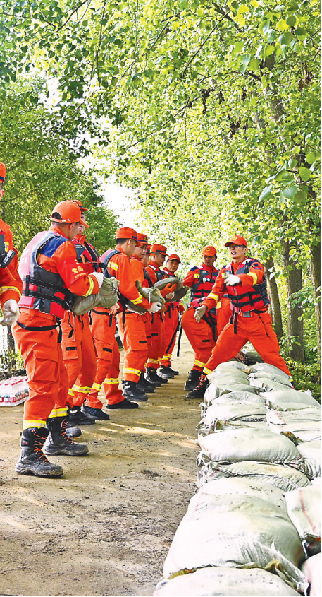
消防员在河道漫水路段筑造防护堤。(湖北日报通讯员 程铖 摄)
