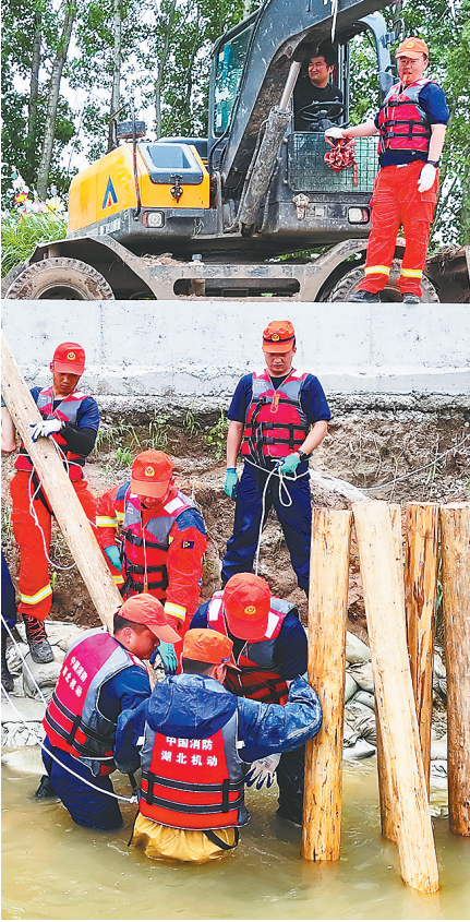
消防员对堤坝迎水坡和堤脚进行加固。(湖北日报通讯员 牛振仓 摄)
