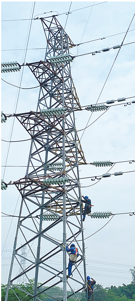
高压电线上安装智联新能的监测装置。
