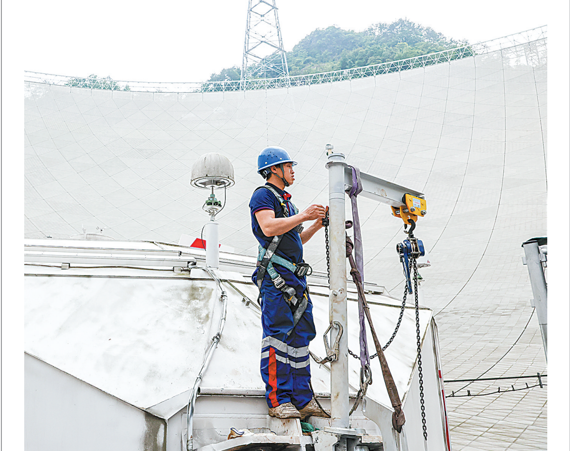
5月6日,工作人员在馈源舱前施工。(新华社发)
