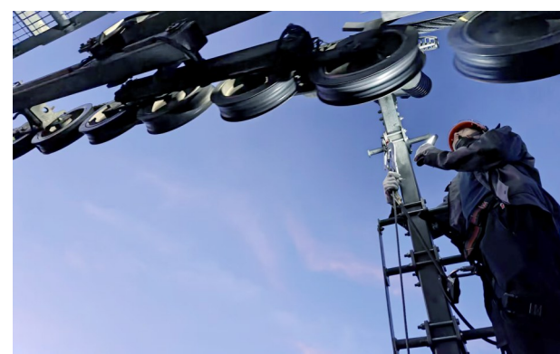
检修员进行支架晚检作业。
