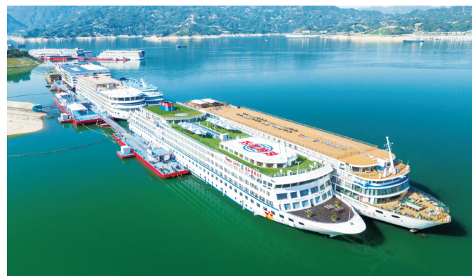
客运游轮停泊在秭归县码头,使用岸电桩补充电力。
