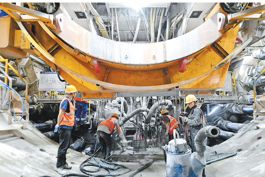
4月20日，在保康县引江补汉工程11号检修交通洞洞输水主隧洞施工现场，“江汉云梦号”TBM加紧掘进。(视界网 陈泉霖 摄)
