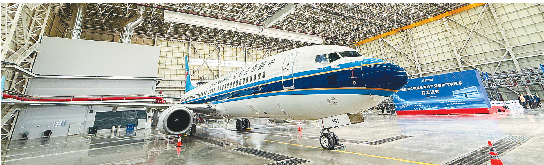
南航湖北喷漆机库可同时容纳两架窄体机或单架宽体机作业。(湖北日报全媒体记者 倪娜 摄)
