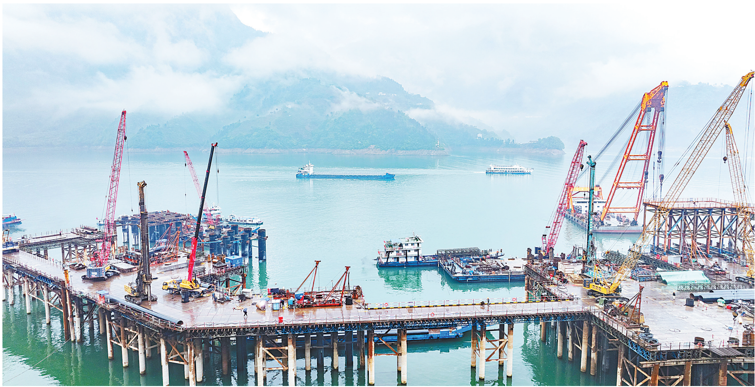
4月13日,秭归县三峡枢纽江南成品油翻坝项目坝上码头工程施工现场,一派热火朝天的繁忙景象。首个墩台浇筑施工任务完成,标志着项目主体工程进入上部结构施工阶段,为后续工程快速推进奠定了坚实基础。(视界网 彭强 摄)
