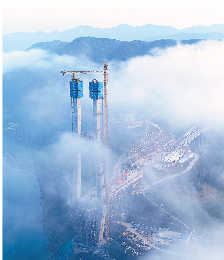
十巫南高速新洲特大桥主塔封顶。(受访者供图)
