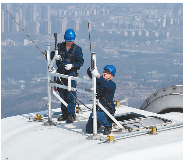
85米高的风机顶端,风力强劲,工程师们系好双钩安全带,检测测风仪,以专业操作守护风机发电精准度。
