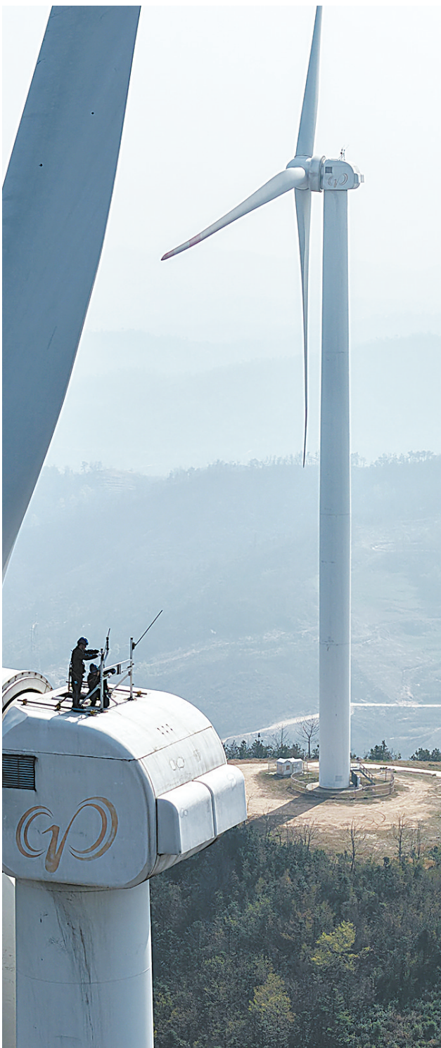
从风机塔底到顶端,从主控柜到测风仪,工程师们分工协作,每一个检查环节都细致入微。
