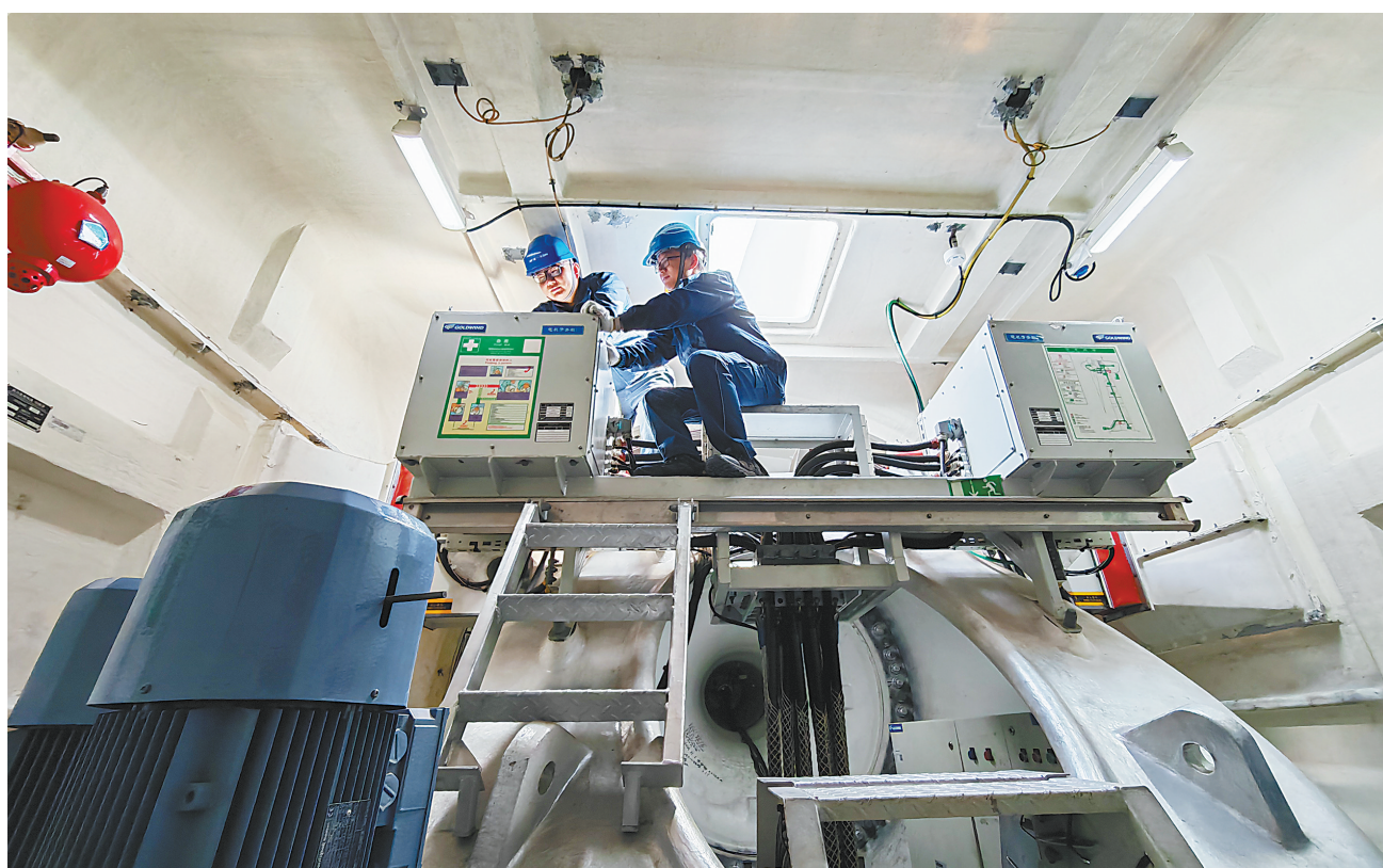
工程师们进行风机机舱断路器柜检查。
