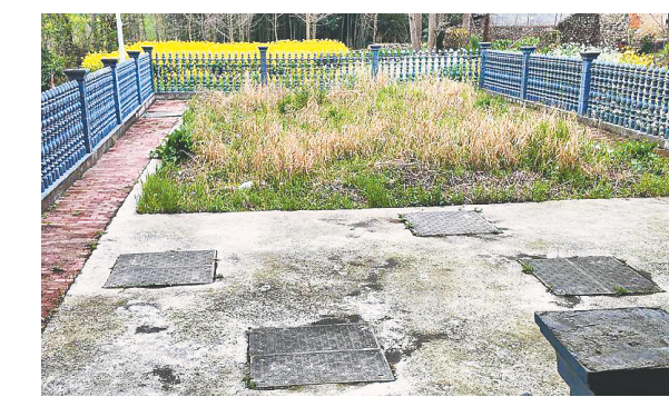
小小的“人工湿地”下有大乾坤,可截留转化周边120户农户的生活污水。(远安县融媒体中心供图)
