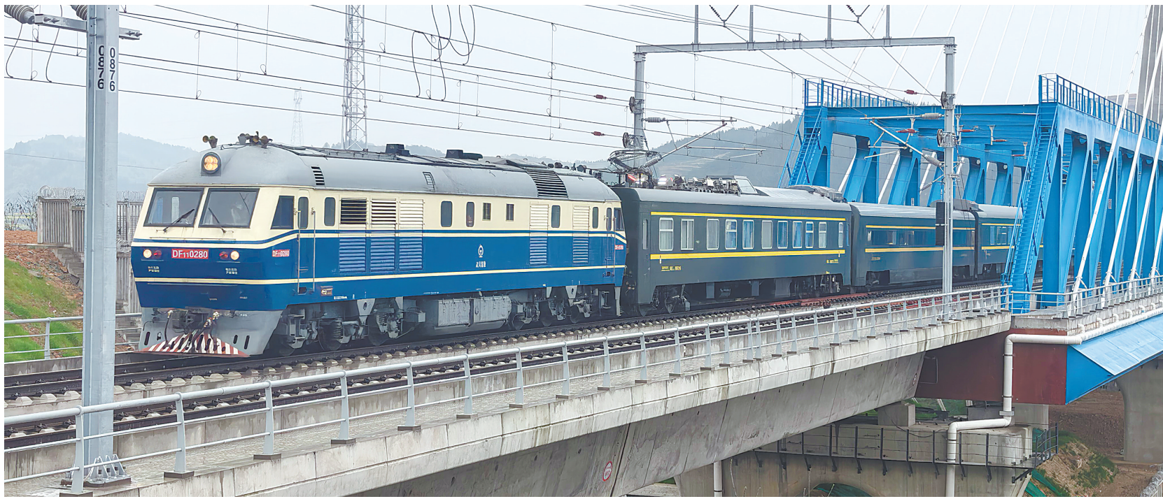
3月24日上午8时43分,首趟专业检测列车驶过汉江特大桥。(湖北日报全媒记者 刘天纵 摄)
