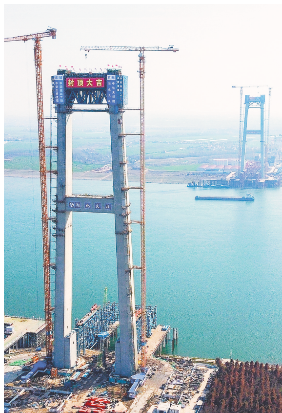
李埠长江公铁大桥施工现场。
