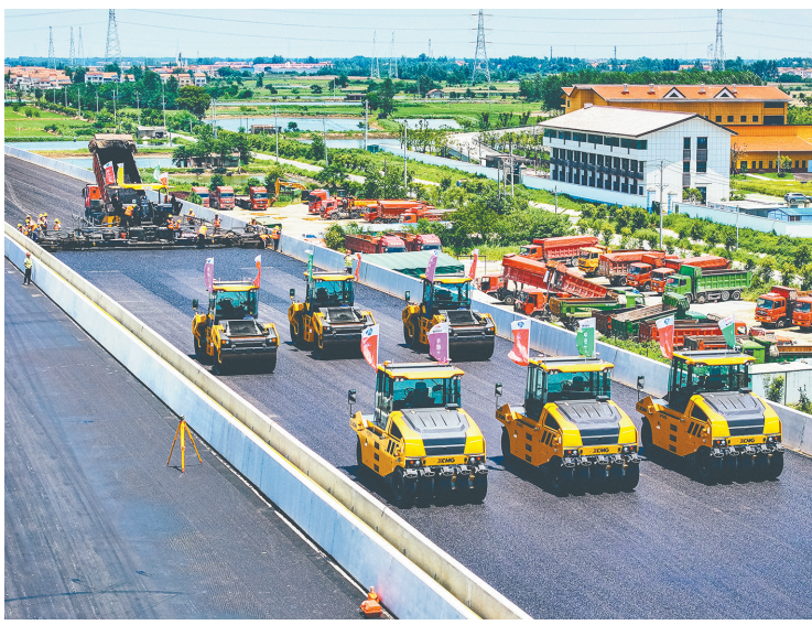
中铁十一局项目部采用无人摊铺技术施工。
