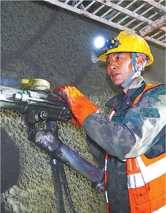
12月8日夜，在平宜高速襄阳段大岭山2号隧道内，工人手持风钻进行钻孔作业。（湖北日报全媒体记者 赵怡然摄）
