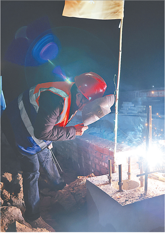
工人正加班进行预埋件焊接。（湖北日报通讯员 李勤摄）
