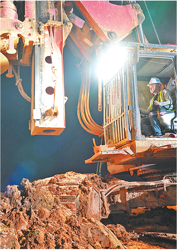
丛伟正在驾驶旋挖机下挖地下桩基孔位。（湖北日报全媒体记者 周升雷摄）
