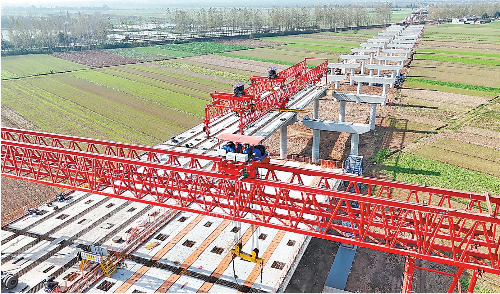
武重高速新港特大桥架梁施工现场。（湖北日报通讯员 李伟 摄）
