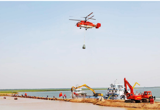
“单线机械立堵、水上船舶抛投、空中定点协同、人工加固复堤”湖北救援力量联合演练水陆空三维封堵决口。
