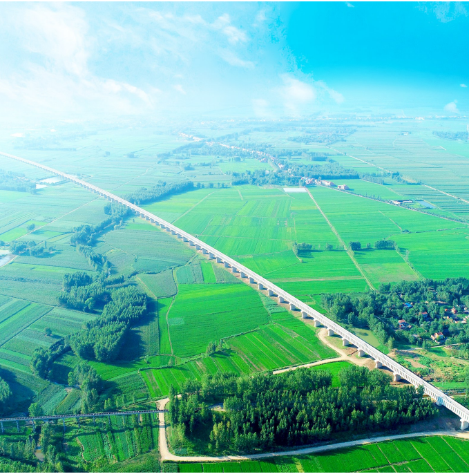
国内规模最大的矩形断面预制渡槽——鄂北工程孟楼渡槽。(柯皓 摄)
