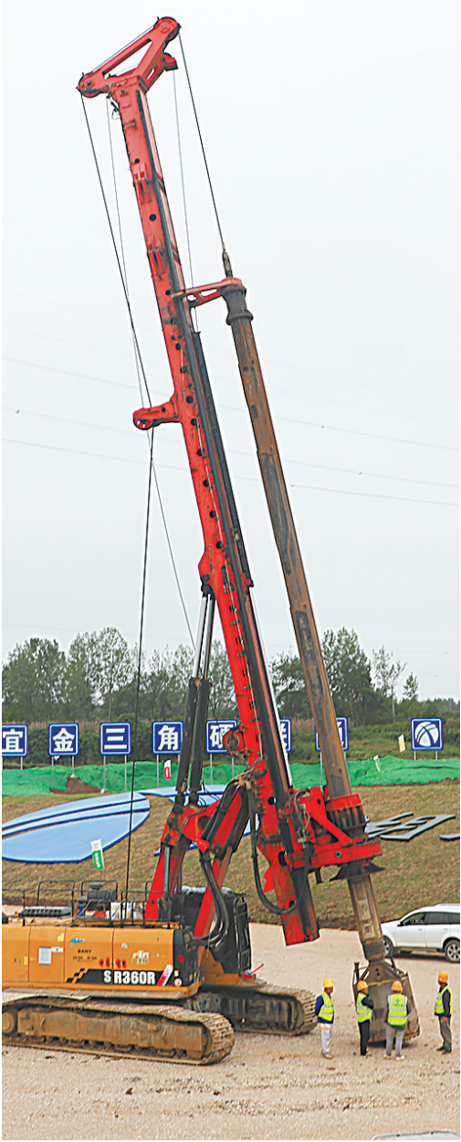
桥梁桩基施工。（湖北日报全媒记者 戴辉 摄）
