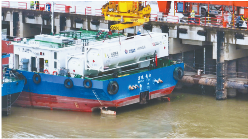
LNG燃料罐精准吊装到位。
