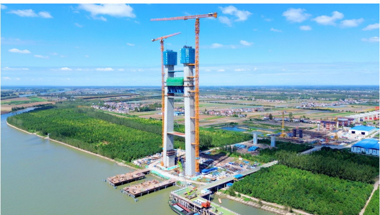
李埠长江公铁大桥主塔拔节升高。
