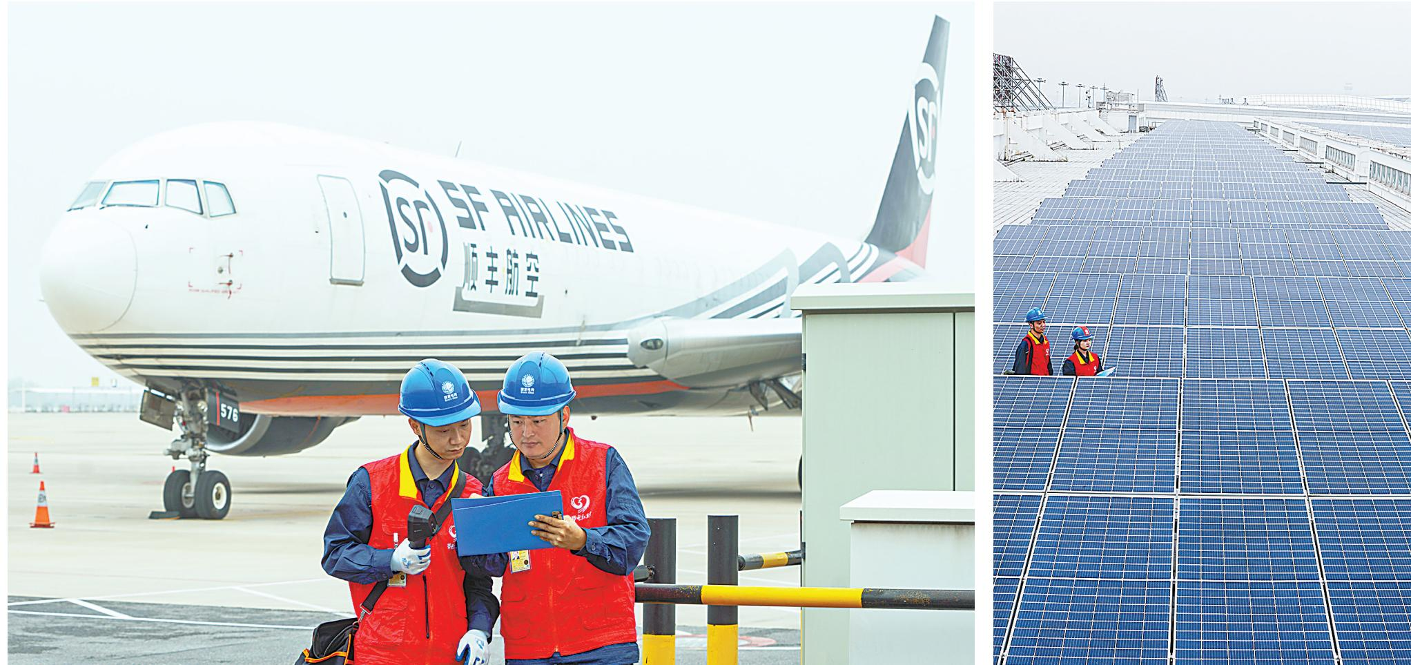
10月17日,供电员工在花湖国际机场巡检光伏发电设施,保障“空中出海口”绿色能源稳定可靠供应。花湖国际机场是我国“四型机场”建设示范项目,屋面光伏约24.7万平方米,光伏幕墙有1.2万平方米,光伏总装机容量约35.09兆瓦,同时安装充电桩853个。自2022年投运以来,该机场
