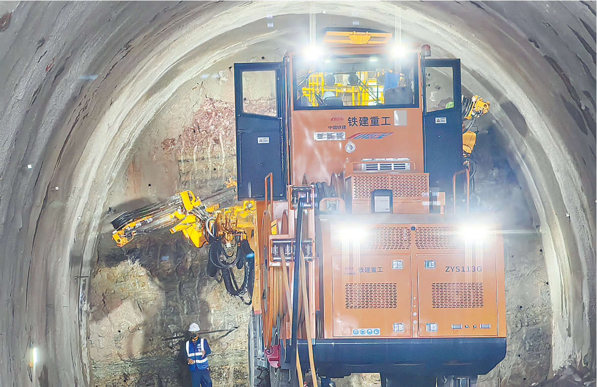
三臂凿岩台车正在隧道内作业。(湖北日报通讯员 陆原 摄)
