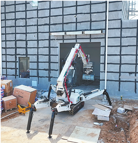
机器“蜘蛛人”在拆装电力设备。(湖北日报通讯员 马磊男 摄)
