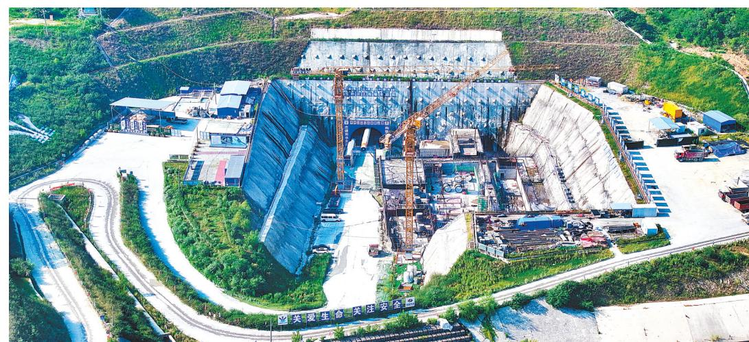
8月3日,位于丹江口市安乐河的引江补汉工程输水总干线出口段,工人冒着高温加紧施工。引江补汉工程从长江三峡库区引水至汉江丹江口水库下游安乐河口,输水线路总长194.7公里。
