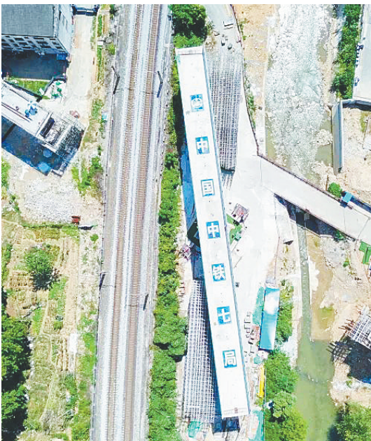
3000吨“钢铁巨人”转体跨越京广铁路现场。 (受访单位供图)
