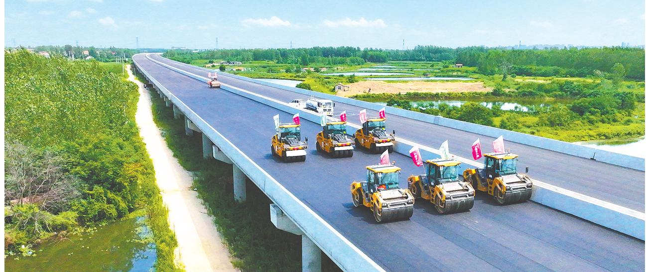
7月25日,烈日当空,无人摊压机群正在双柳长江大桥项目冯家畈大桥段沥青路面进行摊铺。由湖北交投投资建设、中铁十一局参与施工的新港高速双柳长江大桥及接线工程全线路面摊铺工作进展顺利。沥青路面无人化摊铺施工,较传统工艺施工效率提高25%,也避免了操作人员在高温环境下作业。
