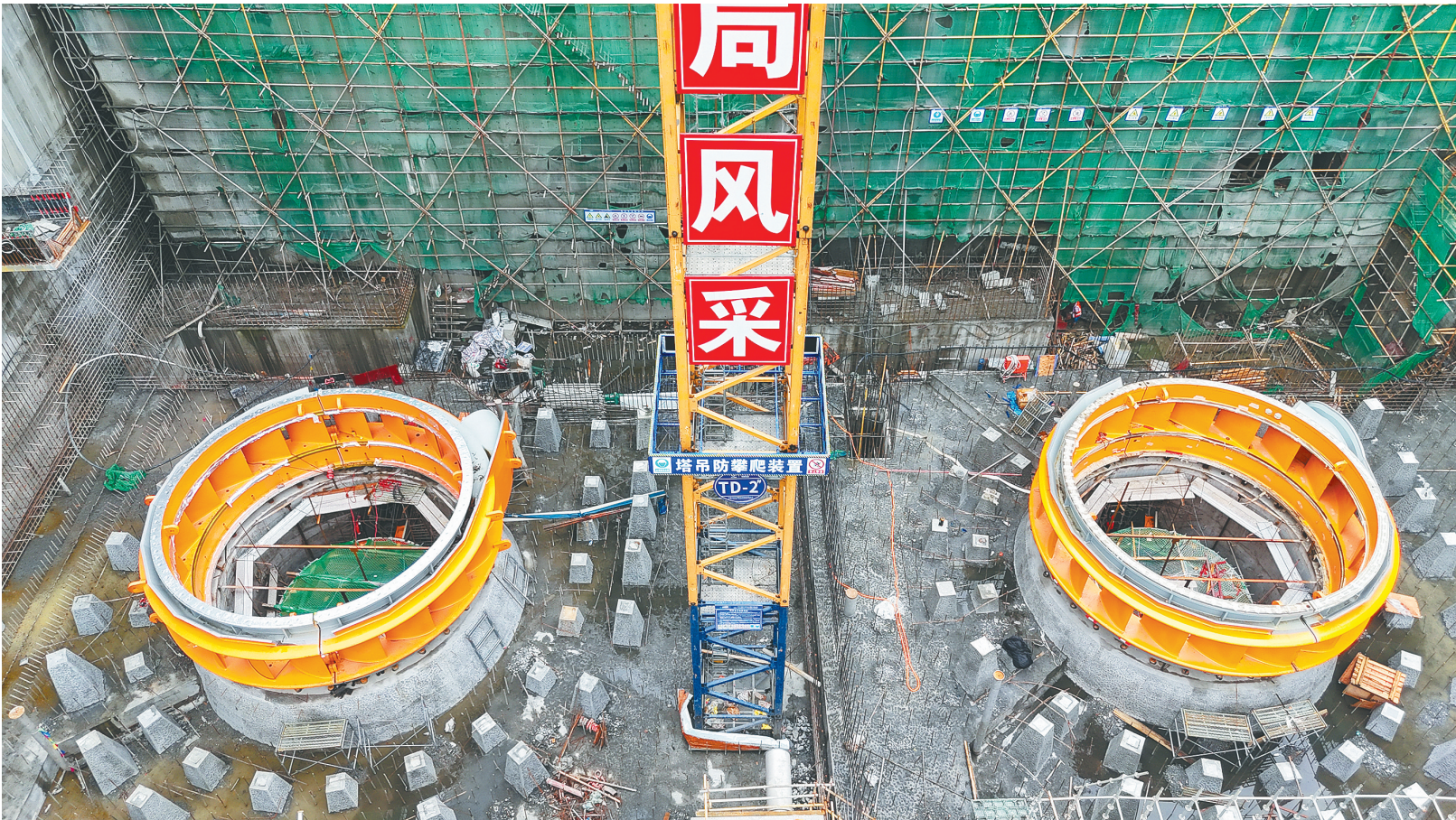
7月16日，潘口抽水蓄能电站两台机组座环顺利安装到位。（湖北日报通讯员 陈宝林 摄）
