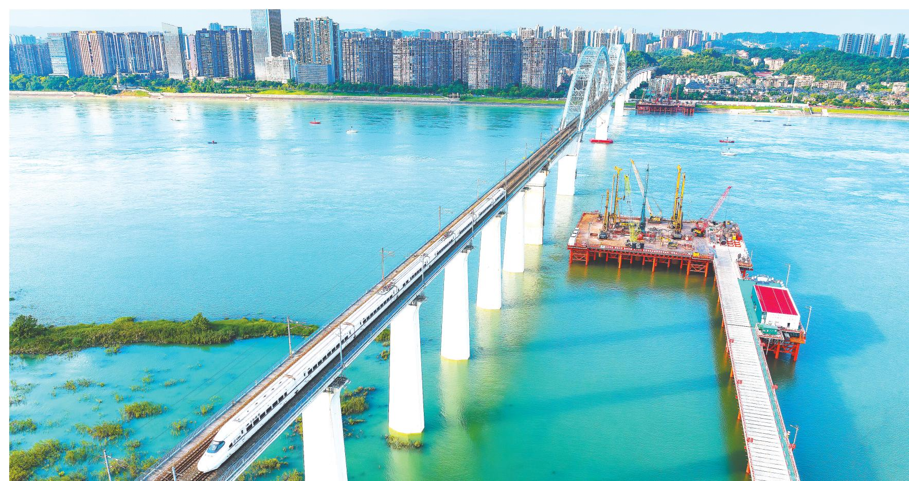
7月10日，一列动车驶过宜万铁路大桥，旁边正在施工的是沪蓉高铁宜昌长江公铁大桥建设现场，建设者正在进行桩基础施工。当年宜万铁路大桥建成通车，历时7年之久。如今，沪蓉高铁宜昌长江公铁大桥与宜万铁路大桥并行，桥梁建设高科技运用，将提高这一沪蓉高铁宜(昌)涪(陵)段关键性工程的建设速度。(视界网 王耿 摄)
