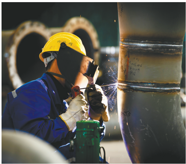
工艺管道焊接是化工施工领域的核心环节,图为六化建工人正在进行焊接作业。
