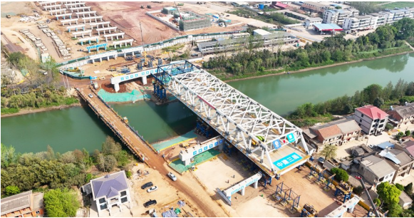
武黄高速改扩建项目柯家墩大桥顶推作业。
