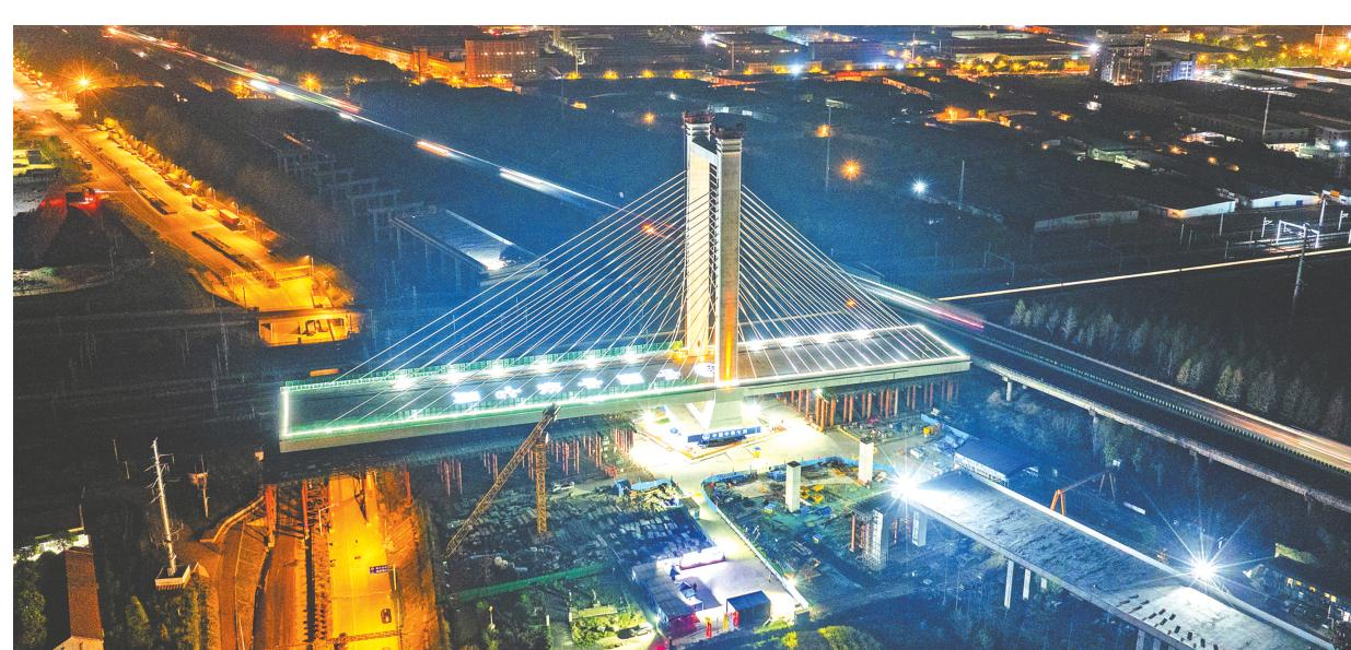
湖北日报讯 (记者胡伟、通讯员李万祥、范昕)3月27日凌晨2时17分,位于武汉市东西湖区高桥二路附近的单塔斜拉桥,在主塔底座6台电动滚轮小车驱动下,以每分钟一度多的速度顺时针旋转,51分钟后,顺利跨越汉宜铁路、汉丹铁路和沪渝蓉高速铁路高桥联络线等三条铁路,转体桥与素有“荆楚第一路”之称的京港澳高速公路完成“甜蜜之吻”。
