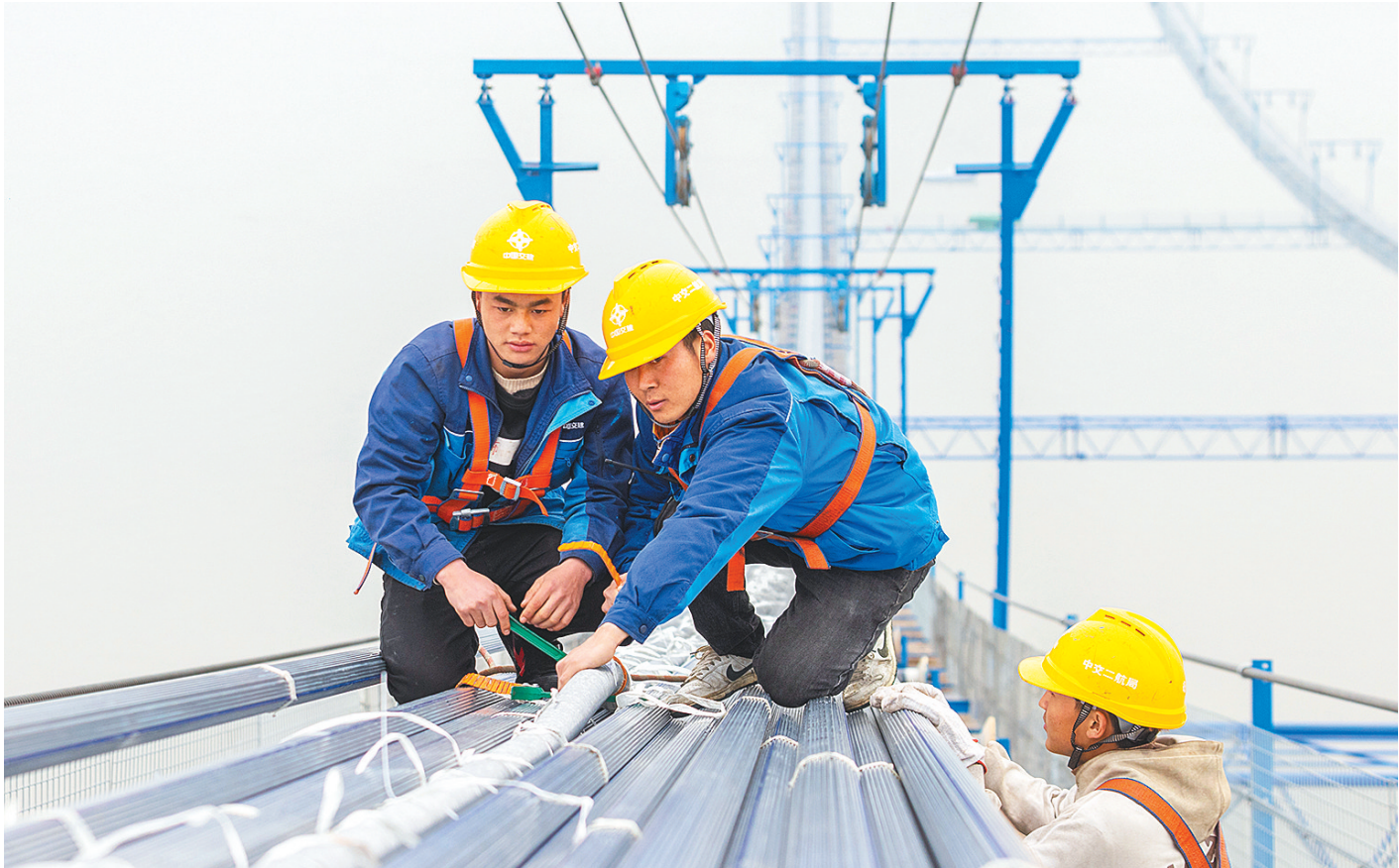
3月13日，工人在双柳长江大桥200米高空猫道上调整通风管道和智慧索股。（湖北日报全媒记者 柯皓 通讯员 黄子坤 摄）
