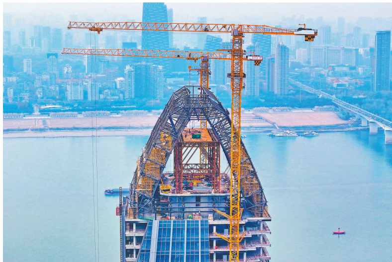
2024年12月30日，武汉市武昌滨江核心区国铁城投中心229米高的T1塔楼顶端，建设者加紧实施合龙后的作业。
