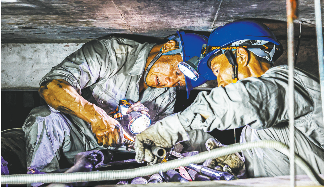
2024年7月,在宜昌市第五人民医院,国网宜昌供电公司抢修队员们顶着酷暑和闷热在医院电缆桥架上更换低压线路。(高丰 摄)
