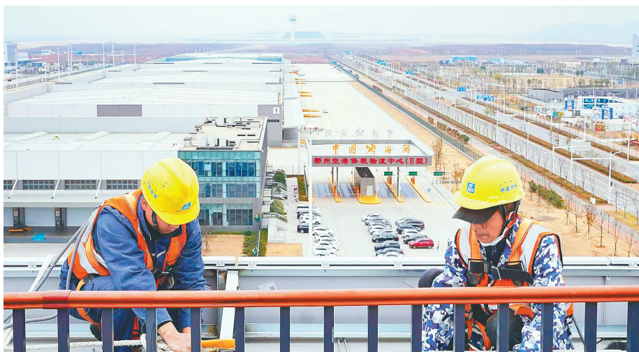
1月14日,花湖国际自由贸易中心,工人正在调试幕墙铝板,不远处,是花湖国际机场的塔台。(湖北日报通讯员 刘沐尧 摄)
