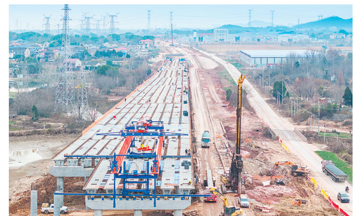
1月8日,武黄高速改扩建项目建设如火如荼,建设者们奋战一线,为项目快速推进赋能。(湖北日报全媒体记者 柯皓 摄)
