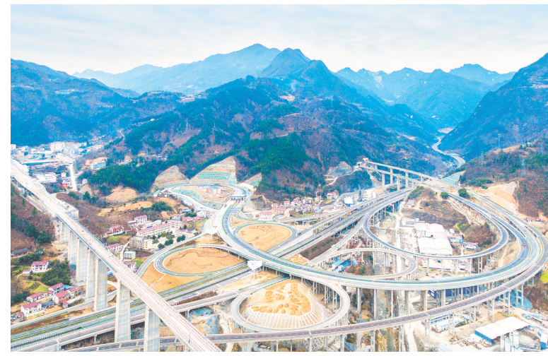
保神高速公路后坪互通枢纽。保神高速公路建成通车标志着湖北所有县市区全部通达高速公路。(湖北日报全媒体记者 柯皓 摄)
