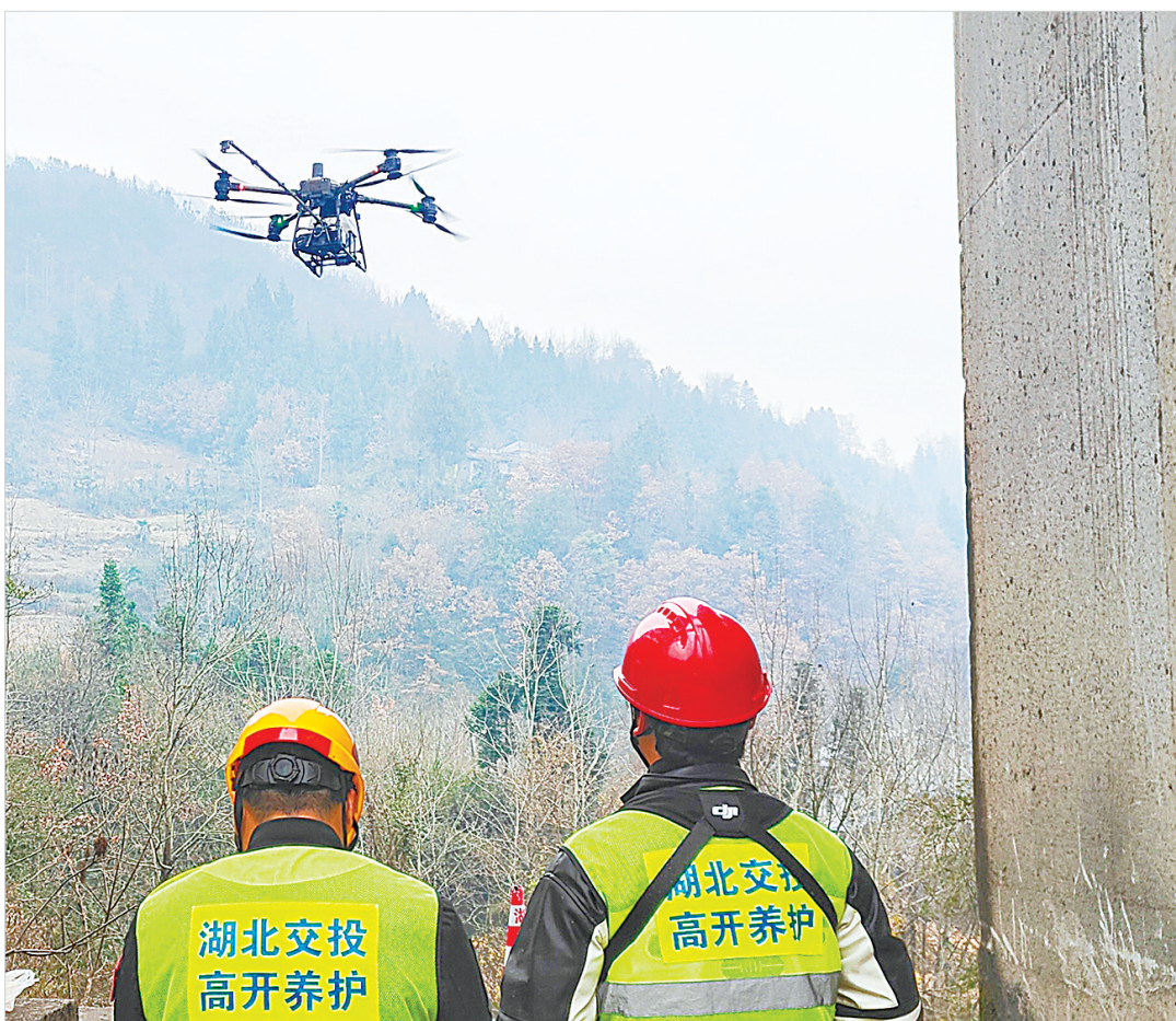
工程师正在操作无人机为大桥智能除锈。(湖北日报通讯员 王勇 摄)
