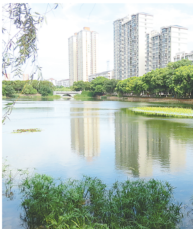
常德市津市市三湖公园，由梁子湖种草队施工完成。(受访者供图)
